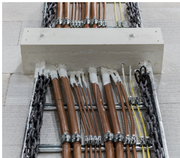
▲ Příklad montážního detailu - zachycení svislého tahu.
